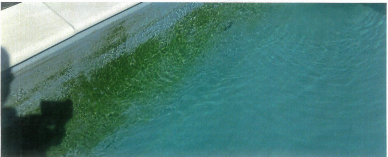
▲ Extremes Biofilmwachstum, da der Roboter die Wände nicht schafft. Umgebaute Poolroboter sind oft nicht geeignet, Naturpoolroboter saugen sich an der Oberfläche fest und reinigen so auch die Wände.
