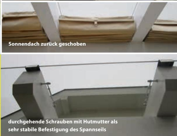
durchgehende Schrauben mit Hutmutter als sehr stabile Befestigung des Spannseils
